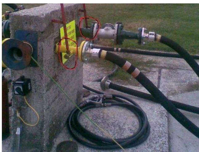
Slika 2. Primer prikaza mesta priključaka creva za pretakanje TNG
