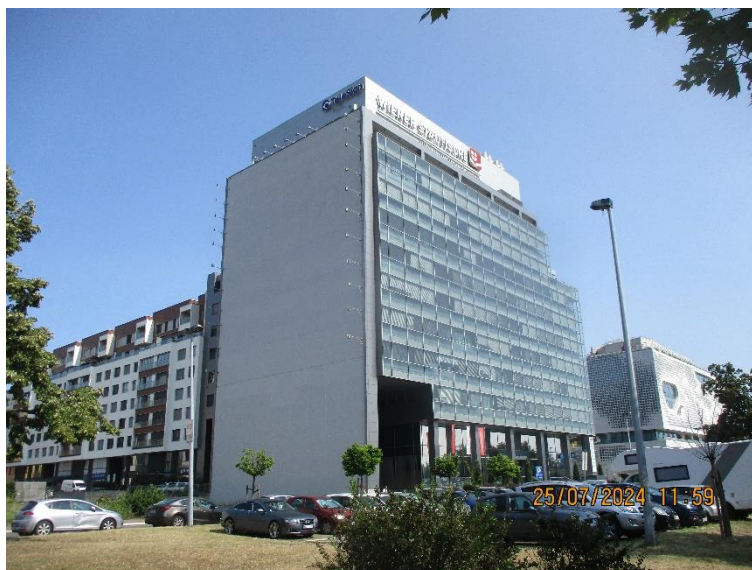
Slika 3: Prikaz objekta na kom se nalazi bazna stanica
