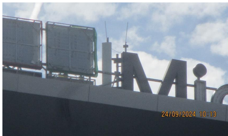
Slika 7: Prikaz antene sektora 3
