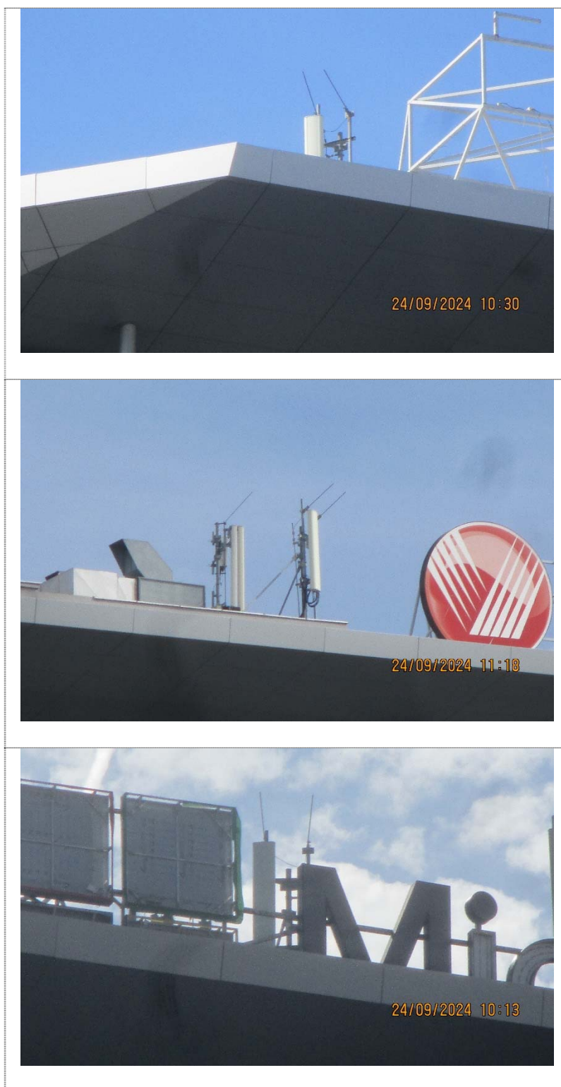
Slika 2.5 Prikaz antenskog sistema, 1, 2 i 3 sektor bazne stanice
