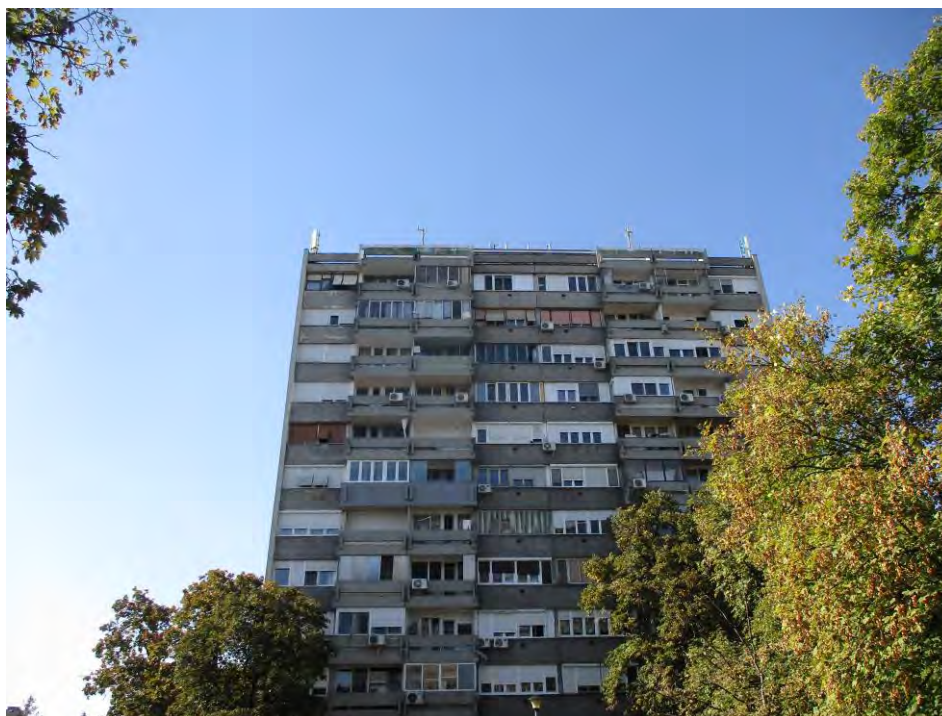
Slika 3.1 Izgled lokacije na kojoj se planira instalacija bazne stanice
