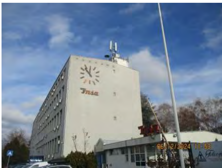
Slika 2.3 Objekat na kome se planira montaža predmetne BS
