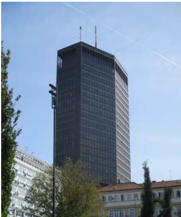
Slika 2.4 Fotografija objekta na kojem se nalazi predmetna radio stanica
