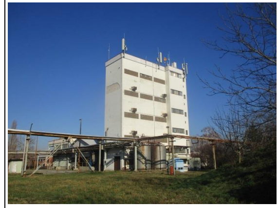
Lokacija bazne stanice
