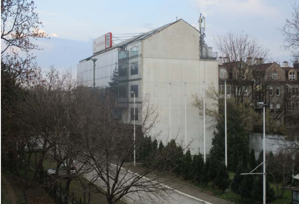
Slika 3.1 Izgled lokacije na kojoj se planira instalacija bazne stanice
