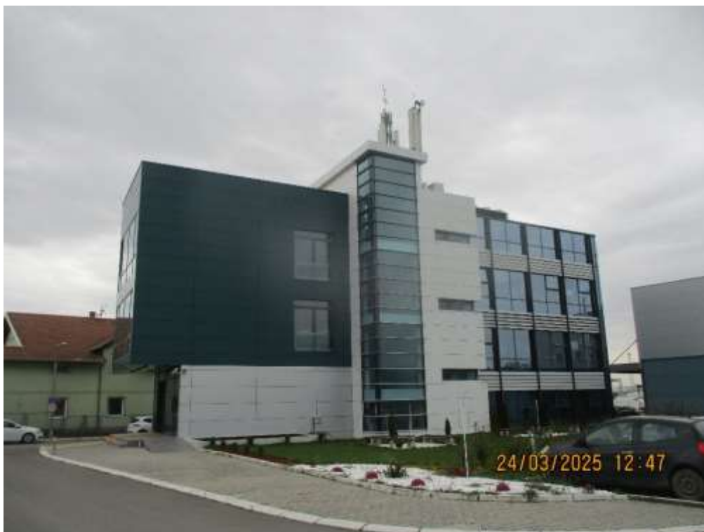
Slika 2.3 Prikaz objekta na kojoj je montirana bazna stanica
