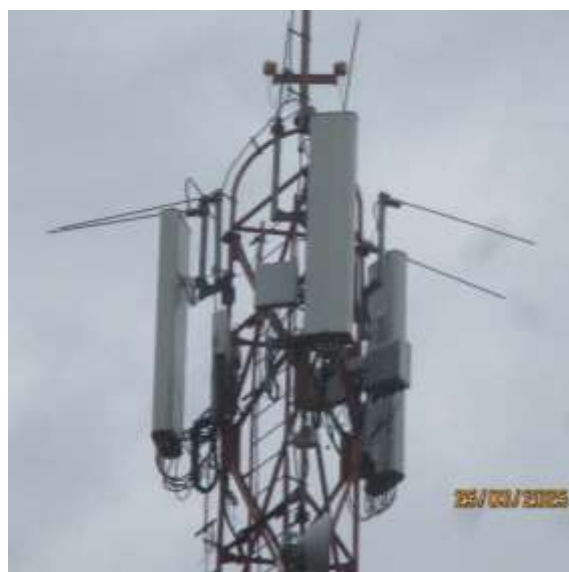
Slika 2.5 Prikaz kabineta i antenskog sistema
