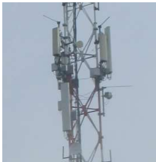
Slika 2.5 Prikaz kabineta i antenskog sistema
