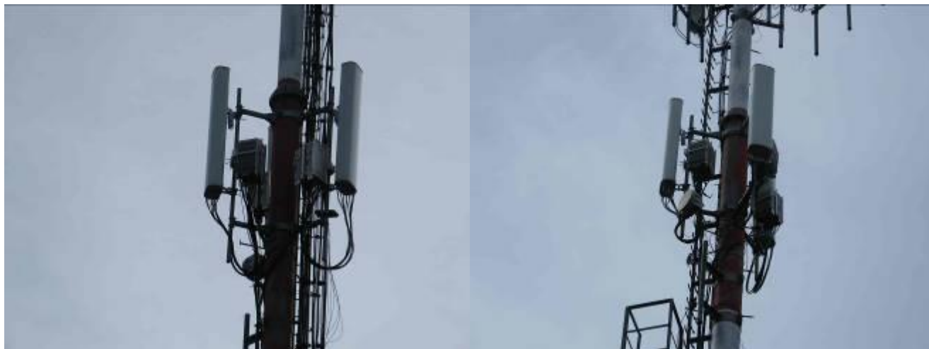
Slika 2.3. Fotografije antenskog sistema i bazne stanice operatera A1 na lokaciji
