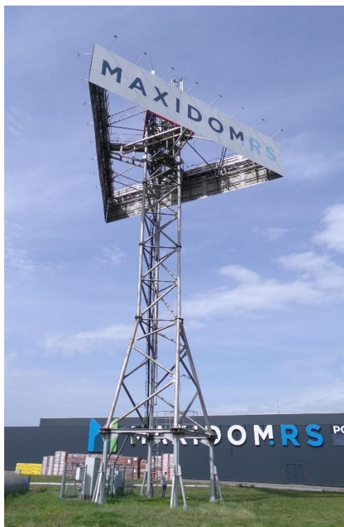
Slika 3: Prikaz reklamnog stuba na kom se nalazi antenski sistem bazne stanice
