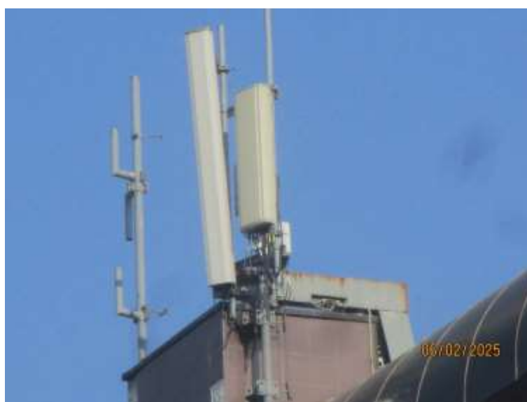
Slika 2.6 Antenski sistem sektor 2 i 3
