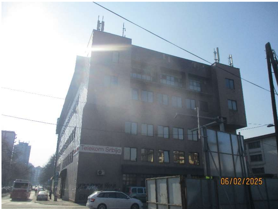
Slika 2.4 Prikaz objekta na kome je montirana bazna stanica
