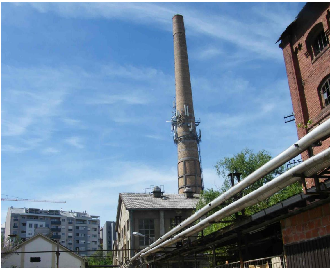
Slika 2.2 Izgled dimnjaka na kom je bazna stanica
