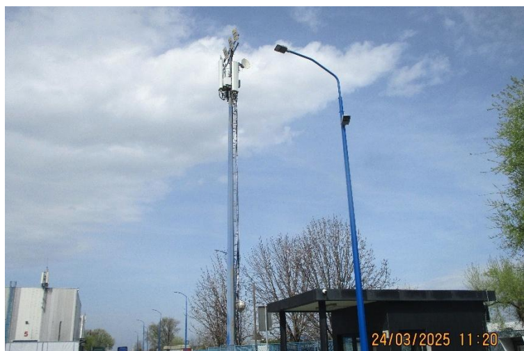
Slika 3: Prikaz stuba rasvete kom se nalazi antenski sistem BS
