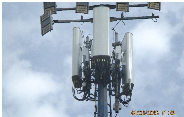
Slika 4: Prikaz antenskog sistema BS
