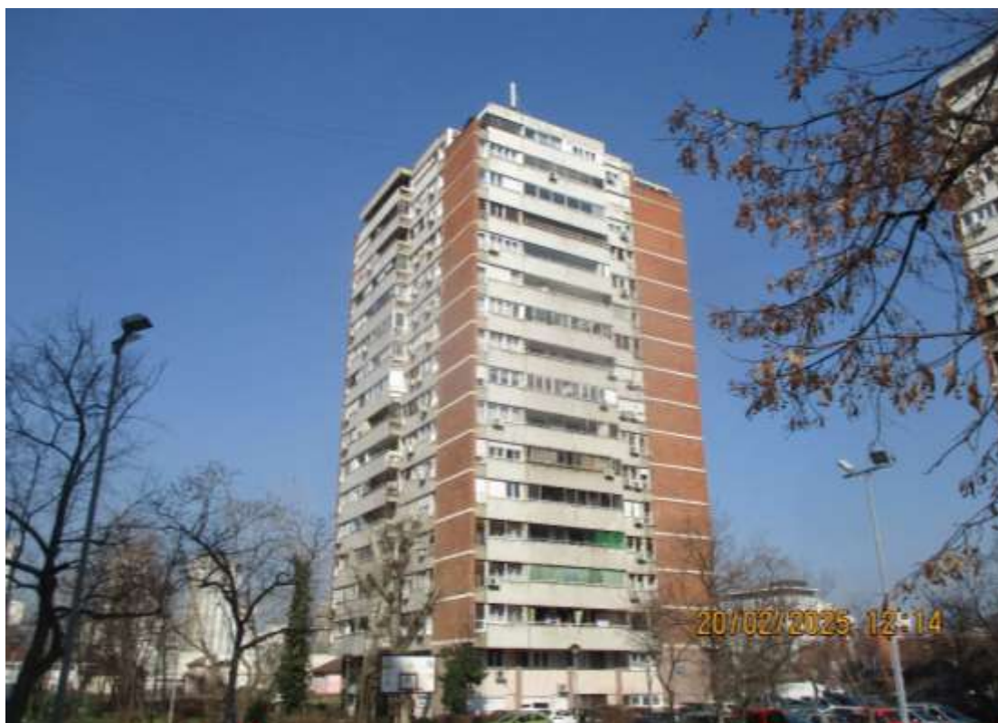
Slika 2.3 Objekat na kom je postavljena BS
