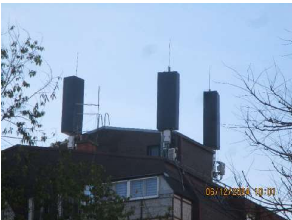
Slika 2.4 Prikaz antenskog sistema, 1, 2 i 3 sektor bazne stanice
