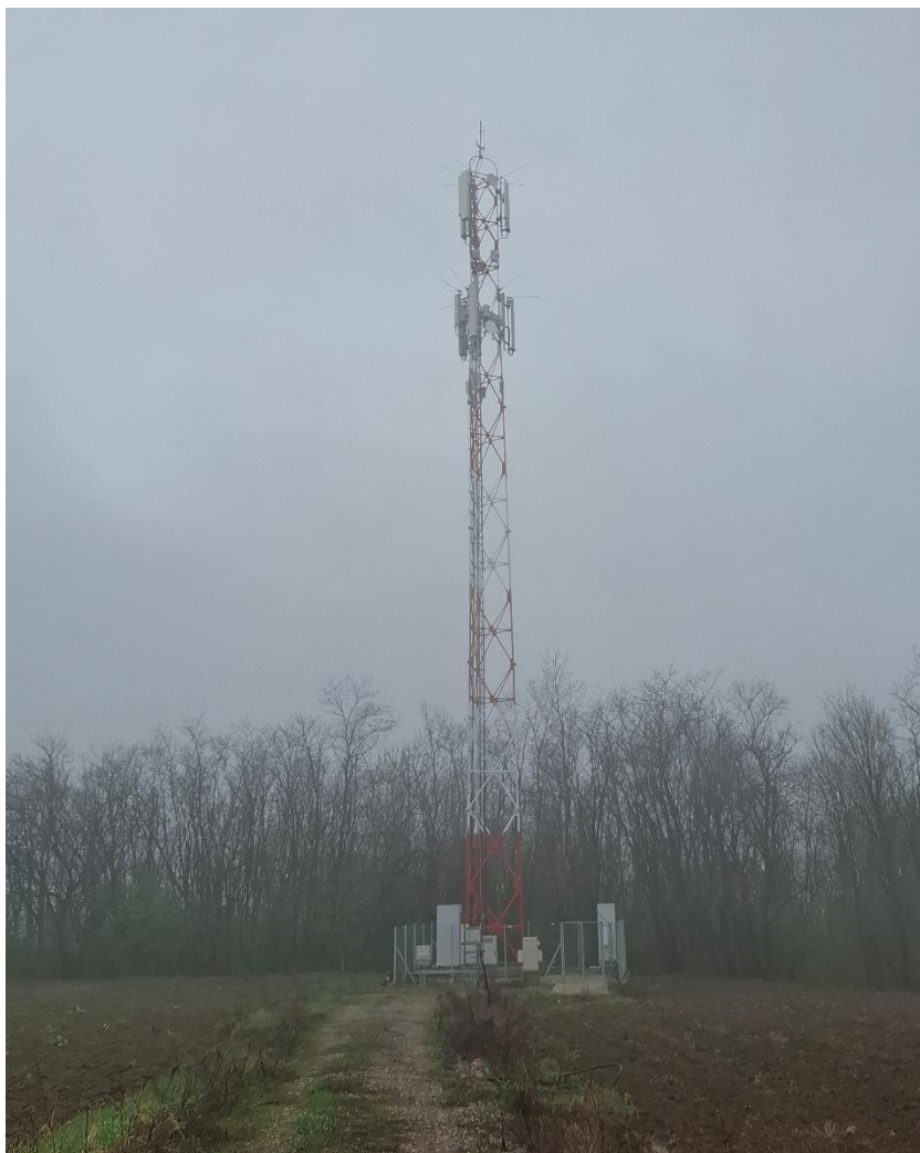
Слика 3.1. Поглед на предметну локацију
