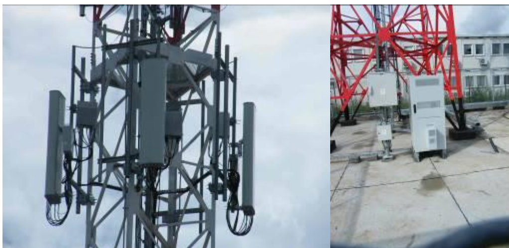
Slika 2.4. Fotografije antenskog sistema i bazne stanice operatera Cetin na lokaciji
