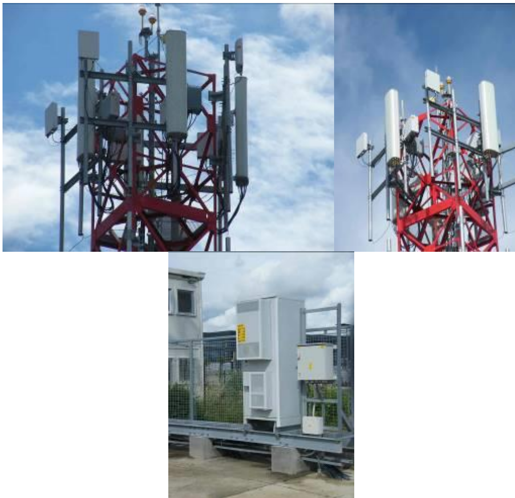
Slika 2.3. Fotografije antenskog sistema i bazne stanice operatera Telekom Srbija na lokaciji
