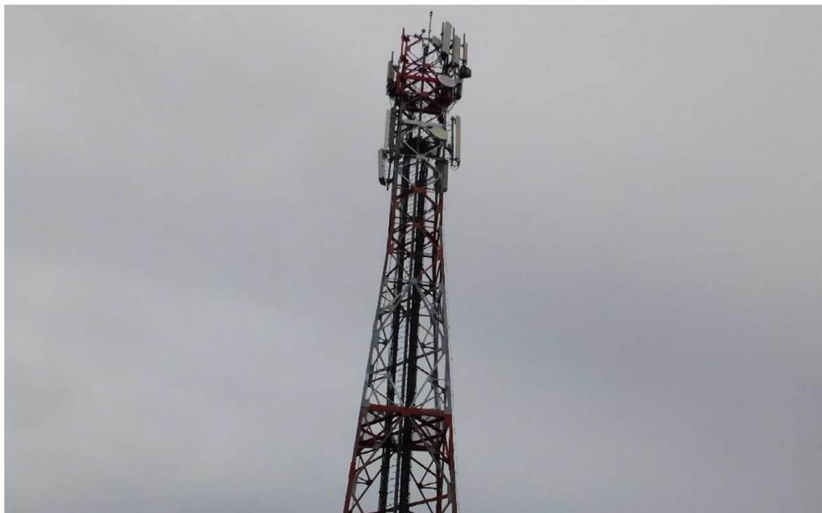
Slika 2.2 Izgled stuba na kom je predviđena bazna stanica BG0606_01 BG_Arapovac
