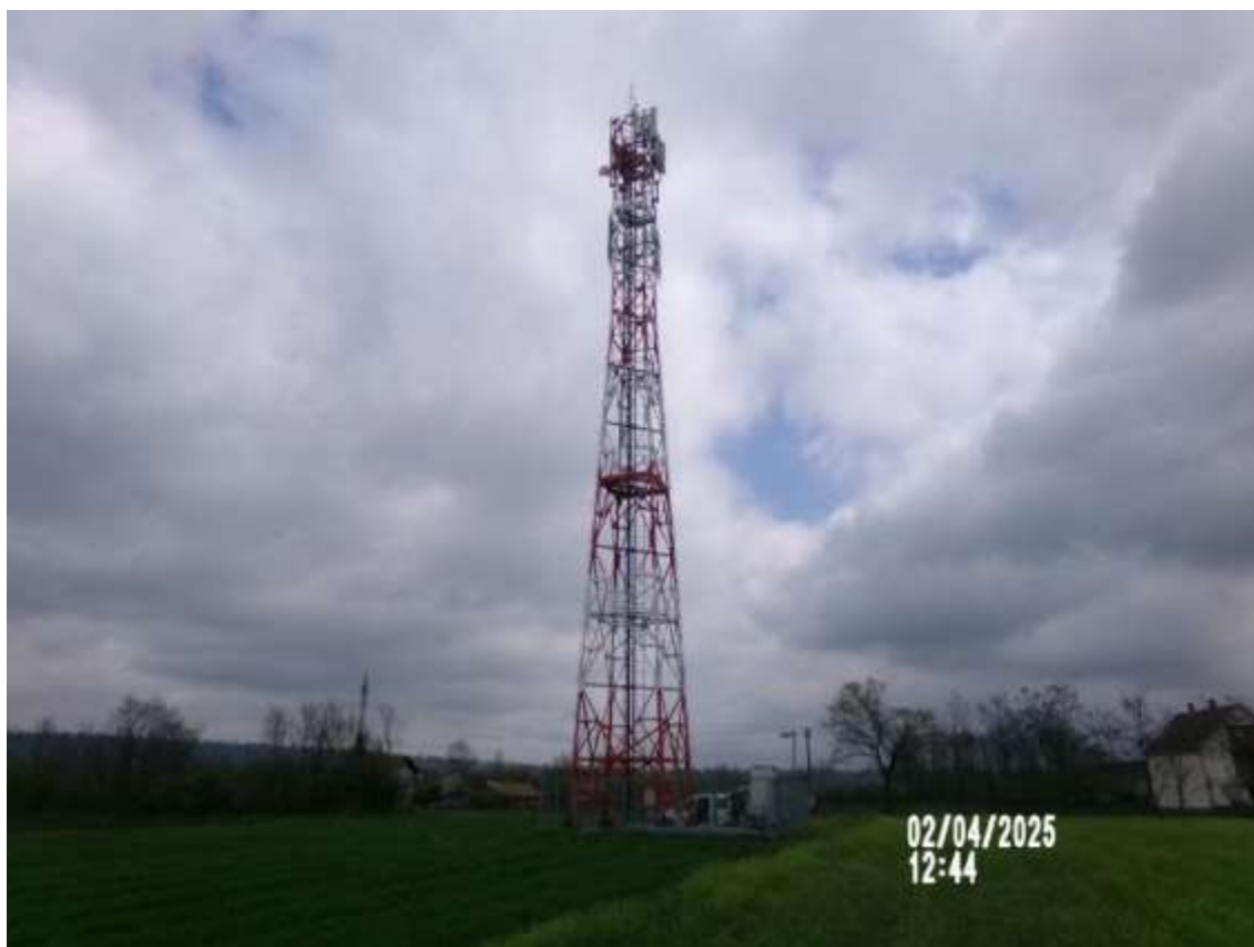
Slika 2.4 Prikaz antenskog stuba na lokaciji bazne stanice
