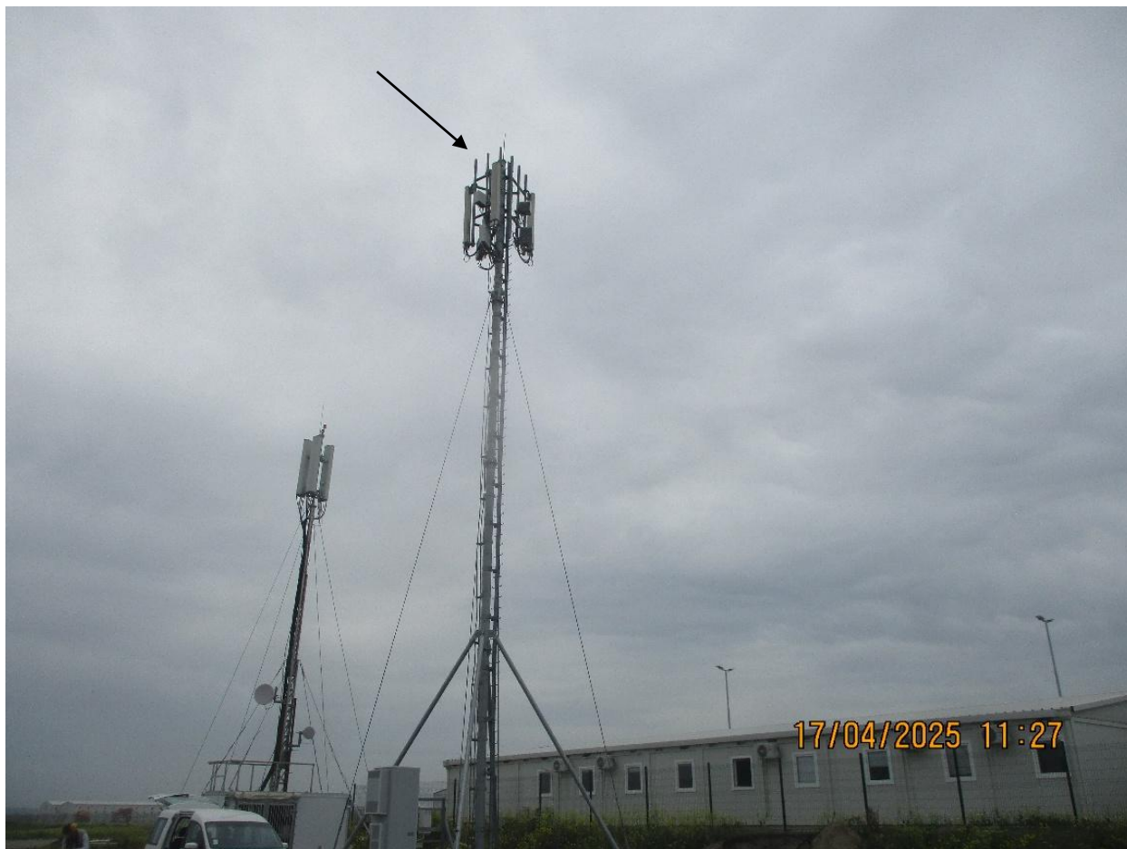
Slika 3: Prikaz montažnog antenskog stuba
