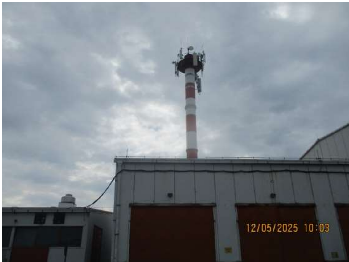
Slika 2.4 Prikaz antenskog stuba na kom je montirana bazna stanica
