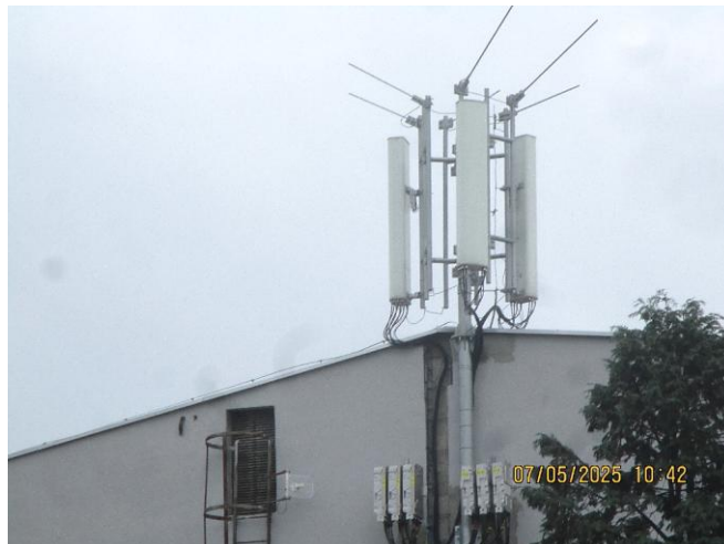
Slika 4 : Prikaz antenskog sistema
