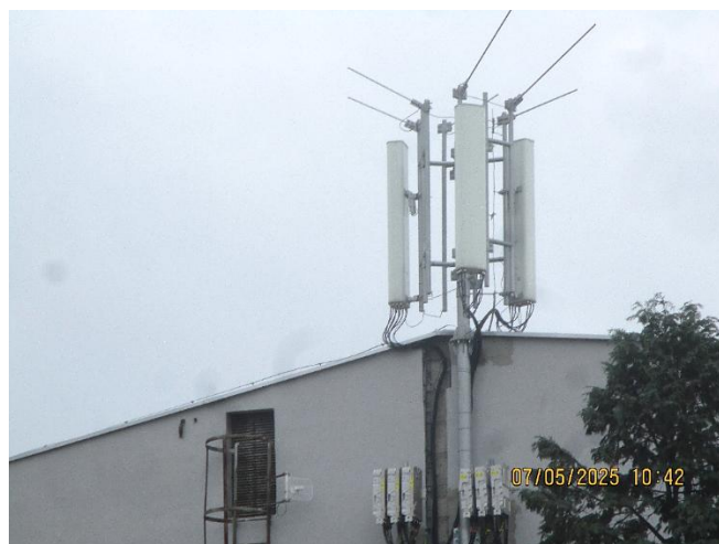
Slika 2.6 Prikaz antenskog sistema, 1, 2 i 3 sektor bazne stanice
