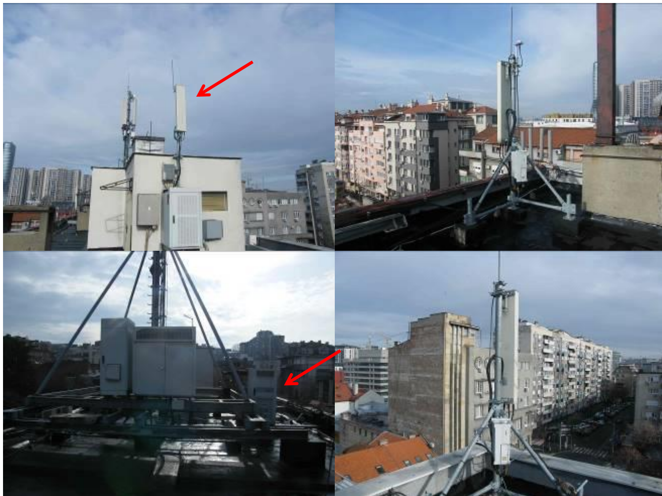
Slika 2.4. Fotografije antenskog sistema i bazne stanice MUP na lokaciji
