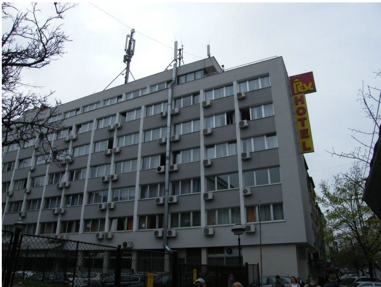
Slika 1.2 Izgled objekta na kom je bazna stanica
