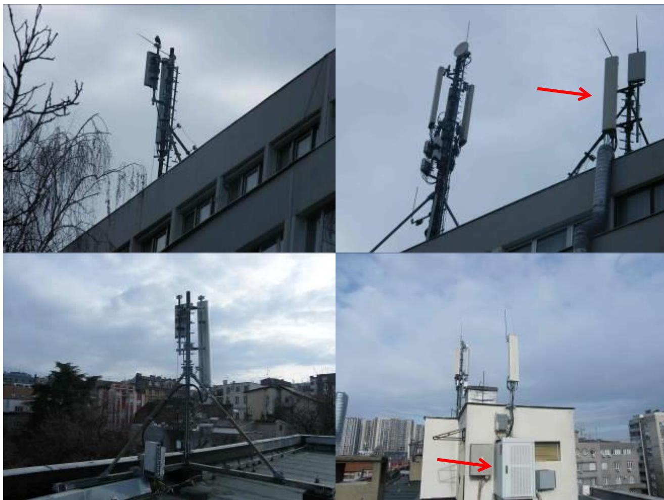
Slika 2.3. Fotografije antenskog sistema i bazne stanice operatera A1 na lokaciji
