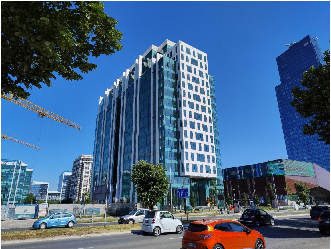
Slika 3: Prikaz poslovnog objekta na kom se planira montaža antenskog sistema bazne stanice
