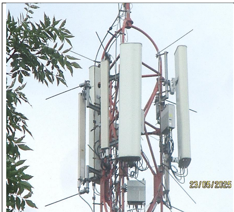
Slika 2.4 Antenski sistem BS
