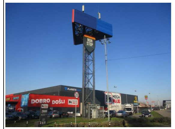
Lokacija bazne stanice
