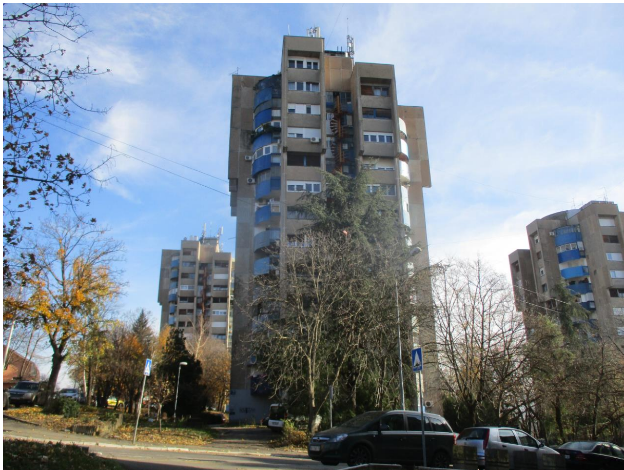
Slika 2.3 Predmetna lokacija RBS „BG - Petlovo brdo“- BG83/BGH83/BGU83/BGL83/BGO83/BGJ83
