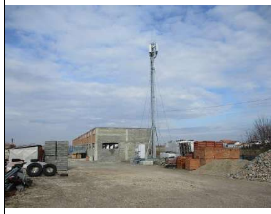
Lokacija buduće bazne stanice
