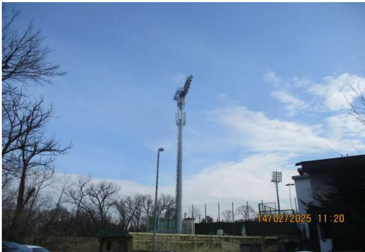
Slika 2.4 Prikaz reflektora na kome je montirana bazna stanica
