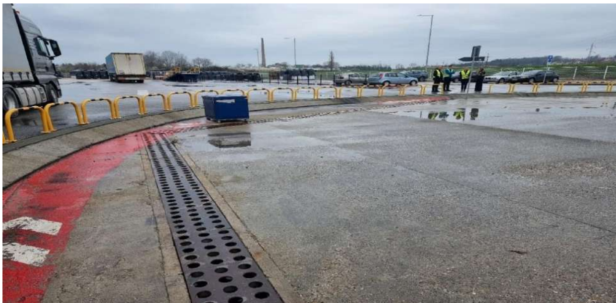
Слика бр.4: Складиште неопасног отпада
