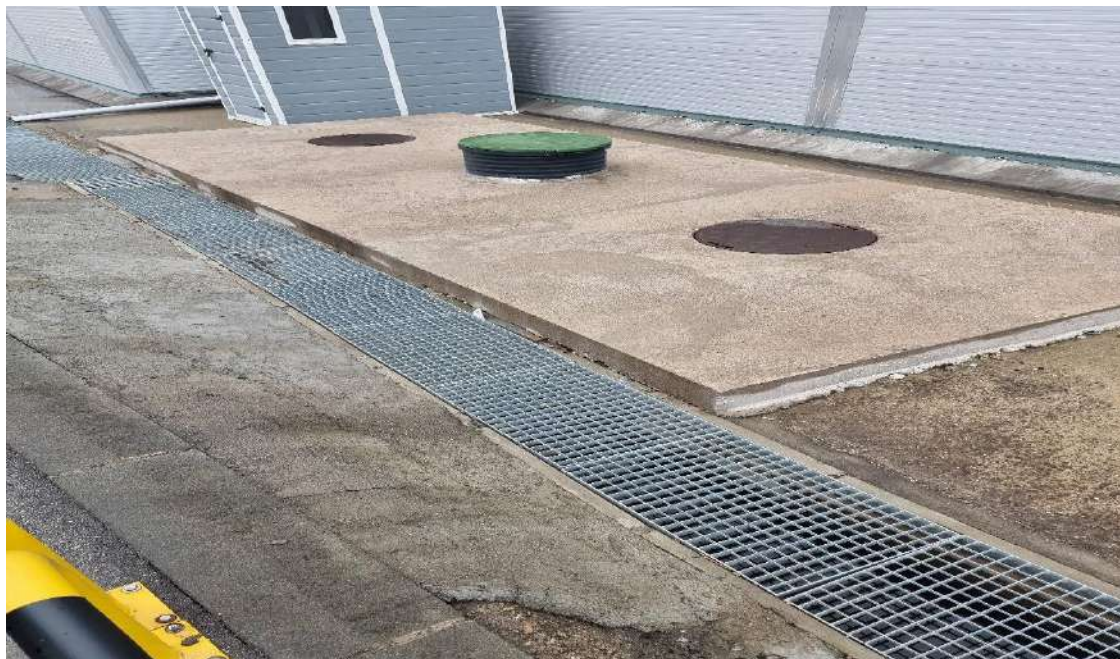
Слика бр. 6: Сепаратор масти, уља и нафтних деривата
