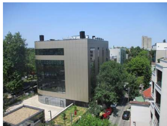
Lokacija buduće bazne stanice
