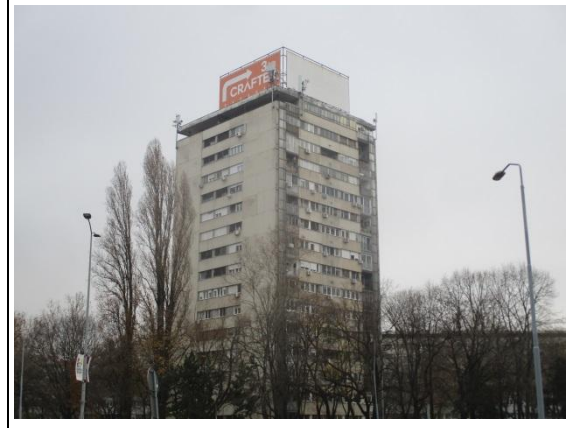
Lokacija bazne stanice
