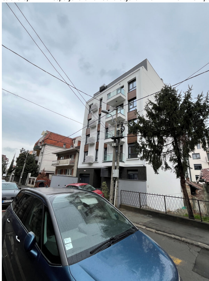
Слика бр. 7 – Изграђени стамбени објект на кп 4223/1 КО Врачар, спратности ЗП0+Су+П+4+Пс
