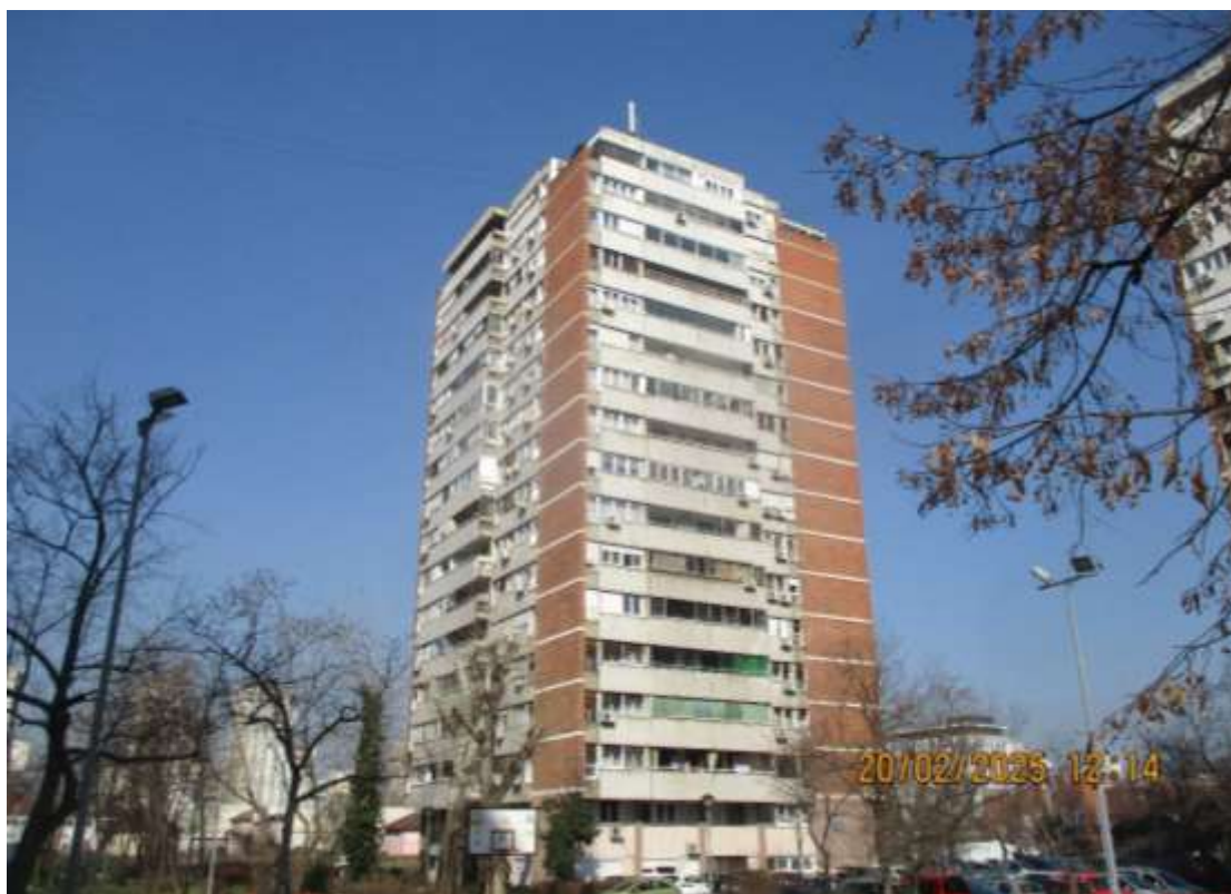
Slika 5.4 Objekat na kom je postavljena BS
