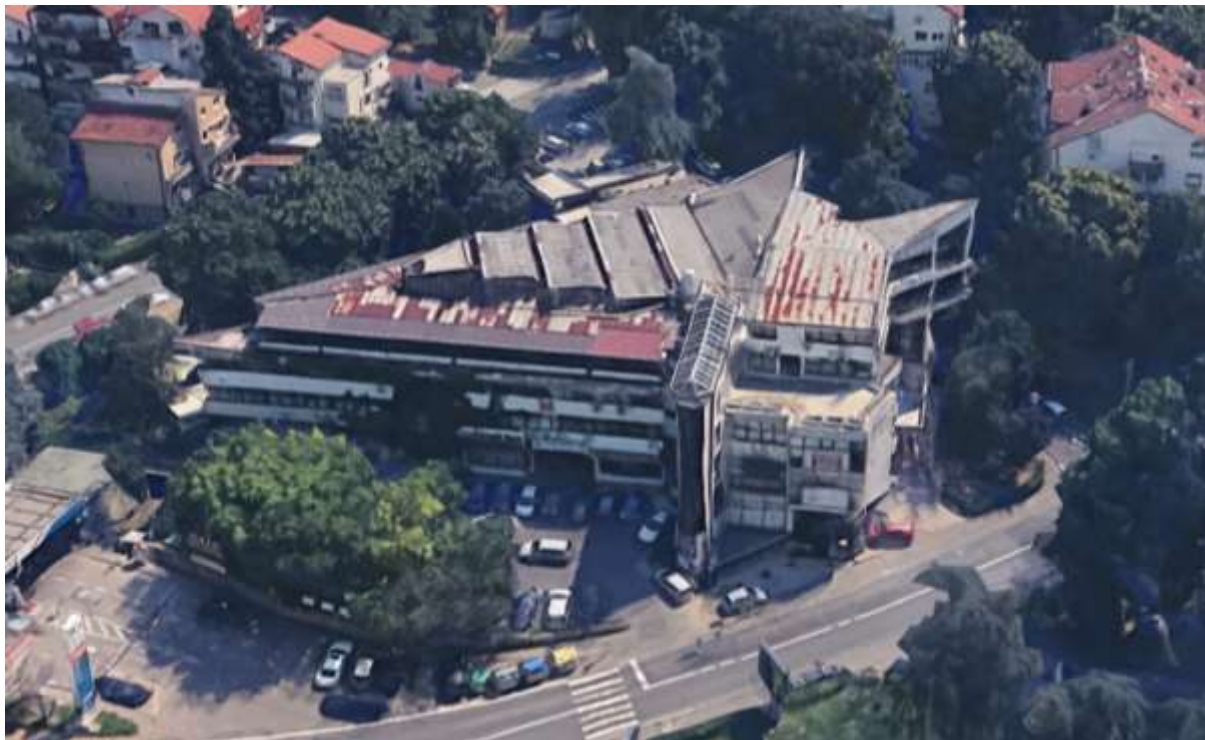
Slika 2.4 Prikaz antenskog stuba na lokaciji bazne stanice
