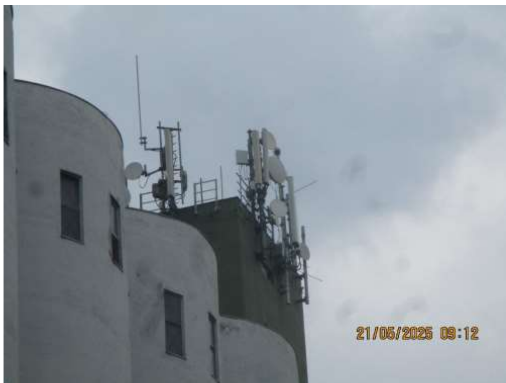
Slika 2.4 Antenski sistem BS
