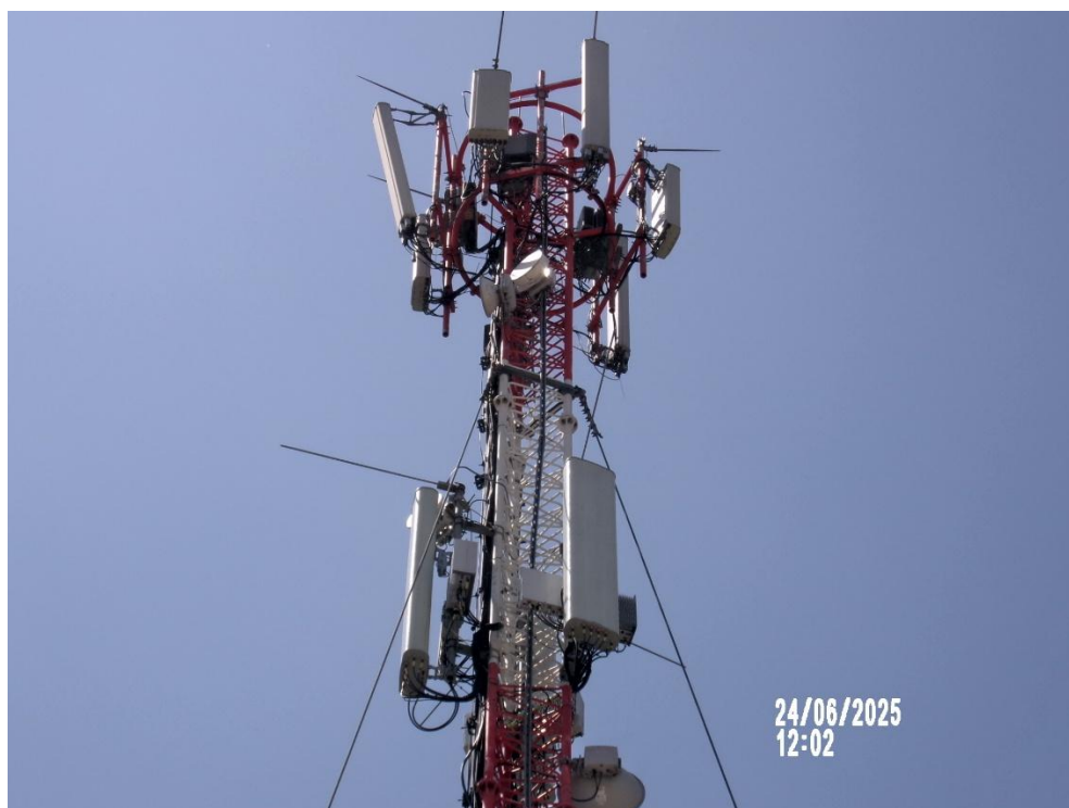
Slika 4: Prikaz antenskog sistema
