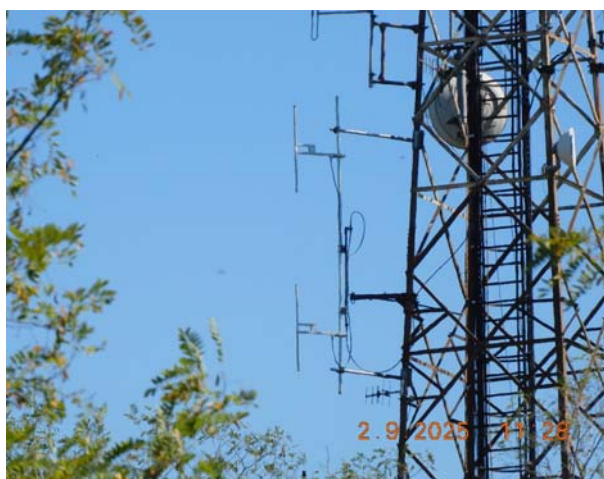
Slika 2.4 Prikaz antenskog sistema radio stanice
