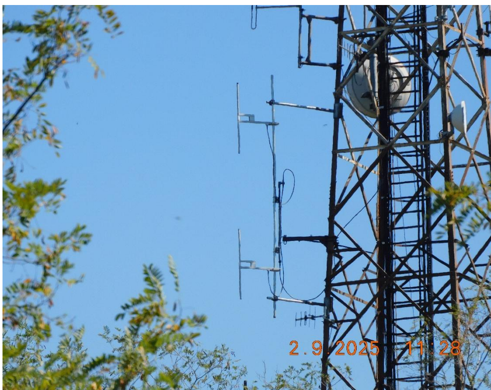
Slika 4: Prikaz antenskog sistema FM radio stanice
