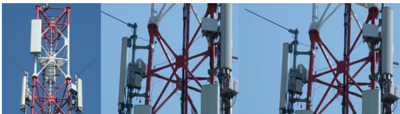
Slika 2.2.b. Fotografija predmetnog antenskog sistema operatora Telekom Srbija i IŽS
