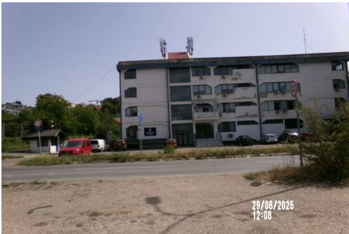
Slika 2.4 Lokacija/objekat buduće bazne stanice Telekom Srbija*
