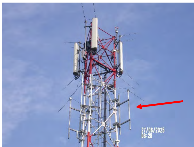
Slika 2.5 Prikaz Telekom antenskih nosača na antenskom stubu
