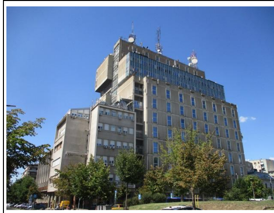
Lokacija bazne stanice
