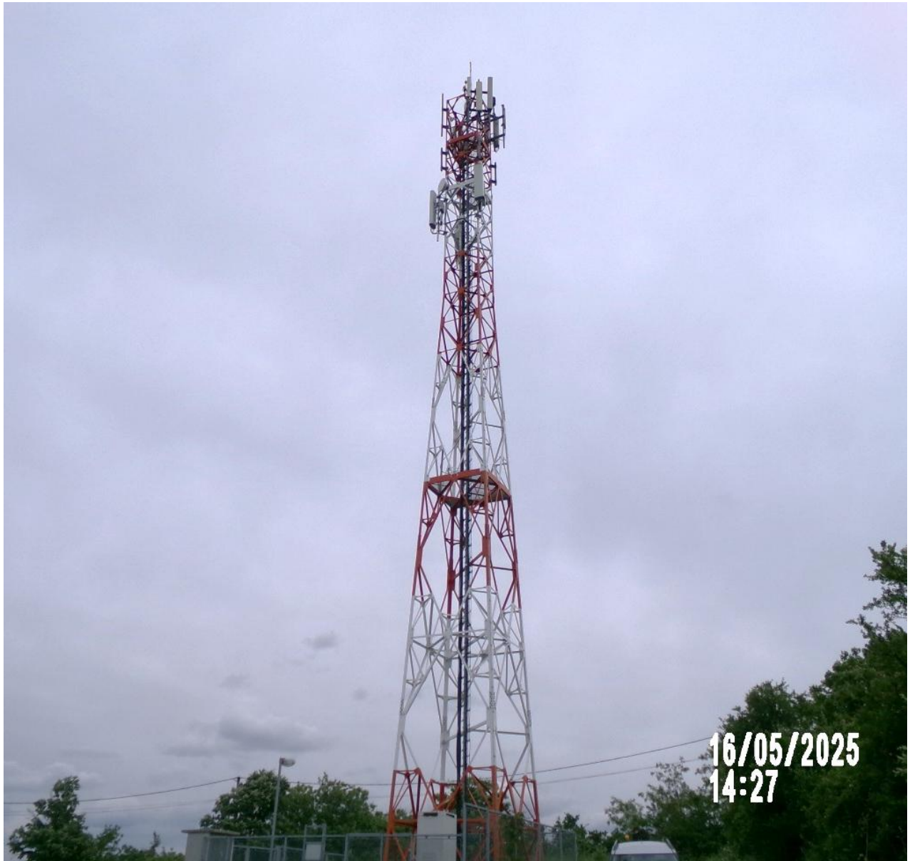
Slika 3: Prikaz antenskog stuba na kom se planira instalacija nove A1 bazne stanice
