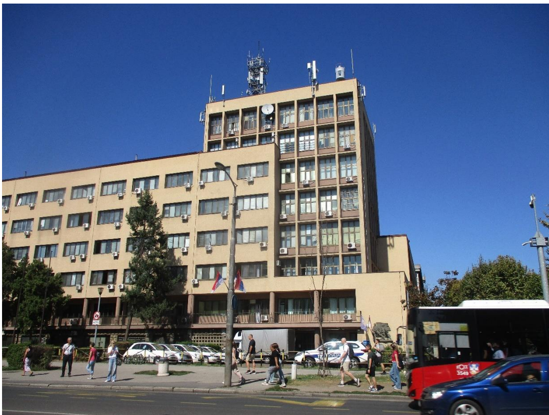
Slika 2.3 Predmetna lokacija RBS „BG-29. novembra MUP“ - BG211/BGU211/BGL211/BGO211/BGJ211
