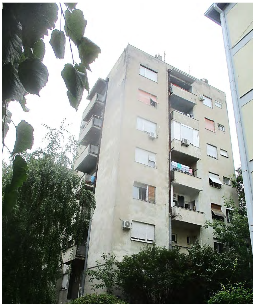
Slika 2.4 Lokacija/objekta Telekom Srbija bazne stanice
