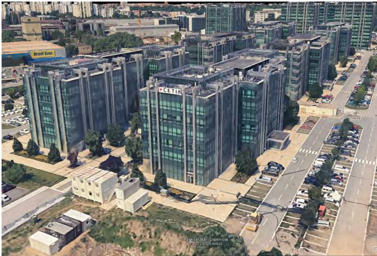
Slika 2.3 Lokacija predmetne bazne stanice (satelitski 3D prikaz)
