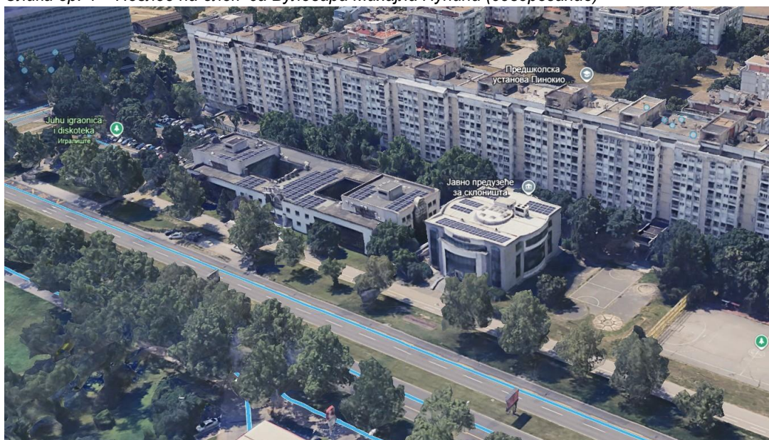
Слика бр. 4 – Поглед на блок са Булеvara Михајла Пупина (северозапад)
